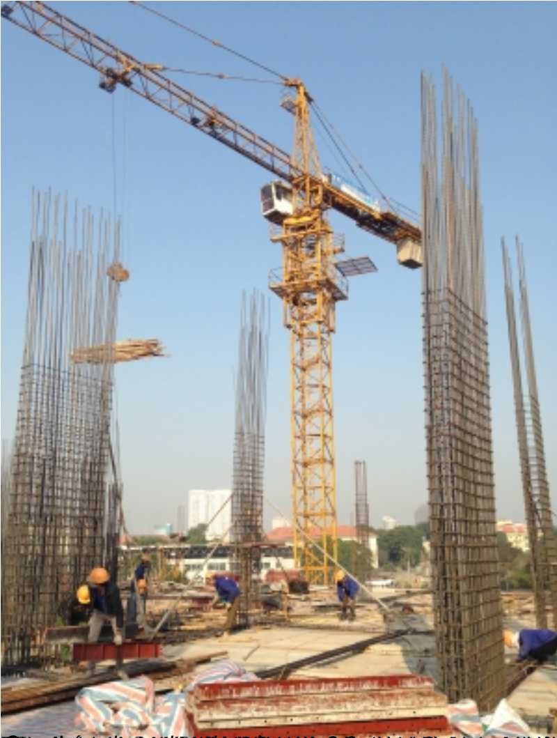
Đang thi công xây dựng các cột bê tông cốt thép tại công trường xây dựng
