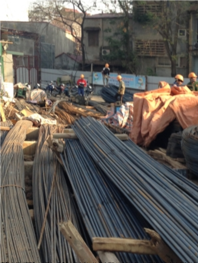
Sơ đồ công trường xây dựng Ký túc xá Đồi học Y Hà Nội. Công nhân đang làm việc trên công trường.
